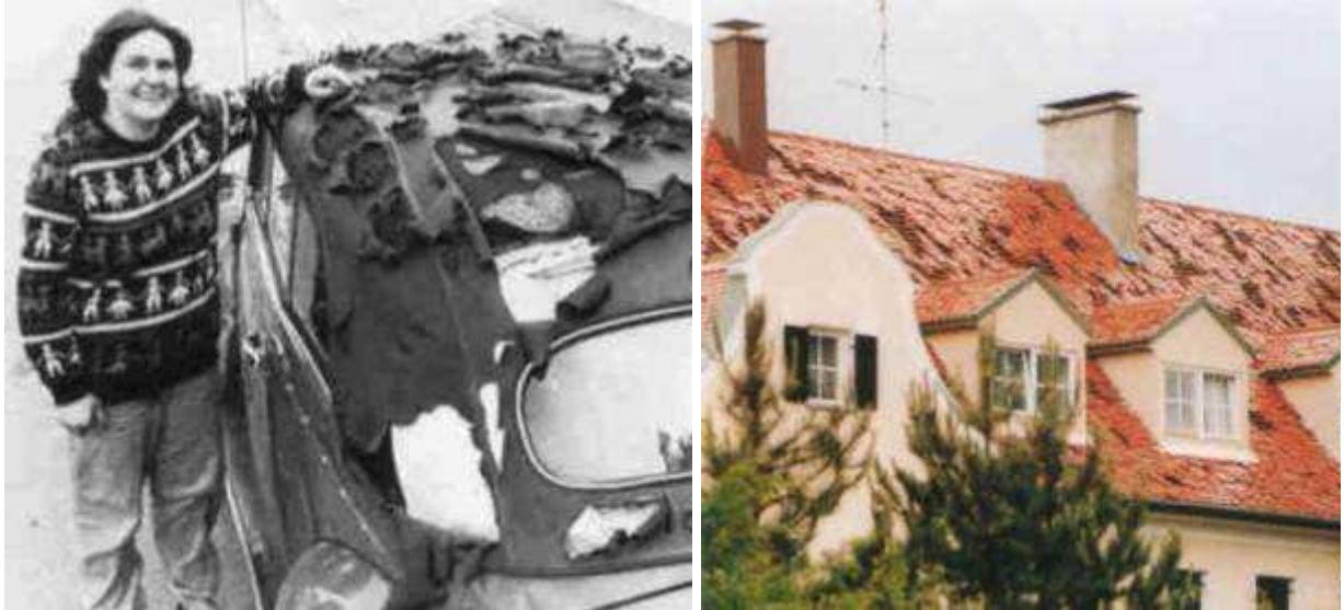
Abb. 4: Der Jahrhundert-Hagelsturm von 1984 hinterließ in München eine Spur der Verwüstung (Fotos: Münchener Rück)
